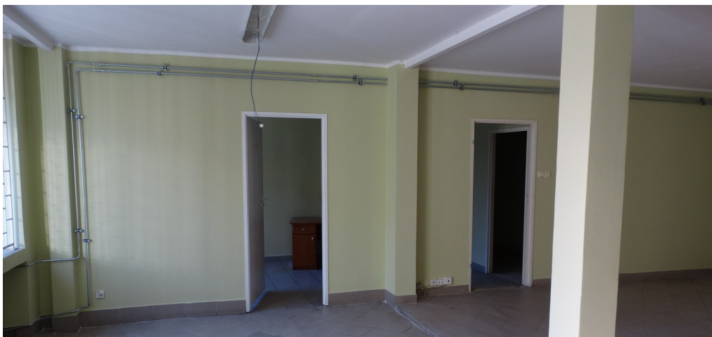
Fot 4 Widok głównej konstrukcji nośnej (słupy)
