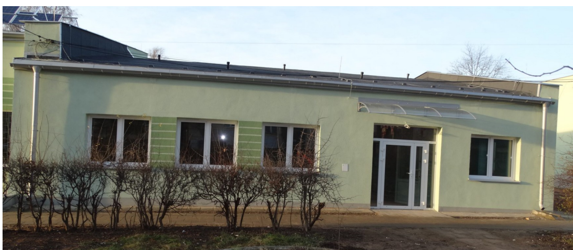
Fot 2 Widok elewacji południowa frontowa południowej frontowej
