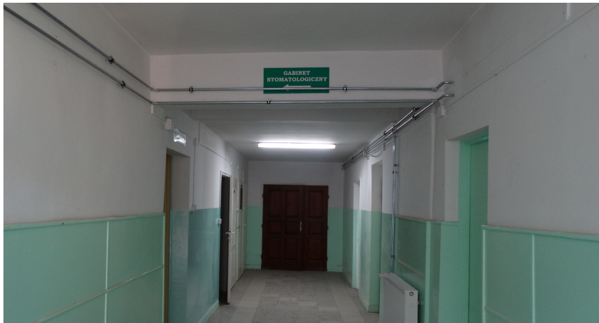
Fot 4 Widok głównej konstrukcji nośnej (podciągi)
