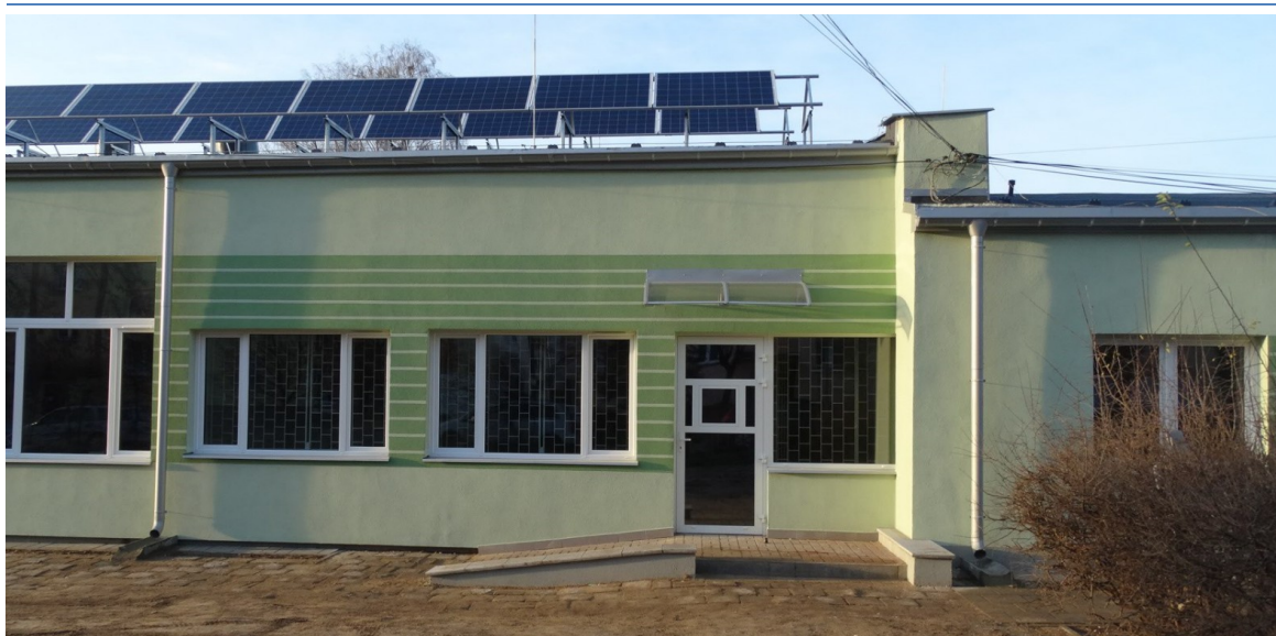
Fot 1 Widok elewacji południowej frontowej
