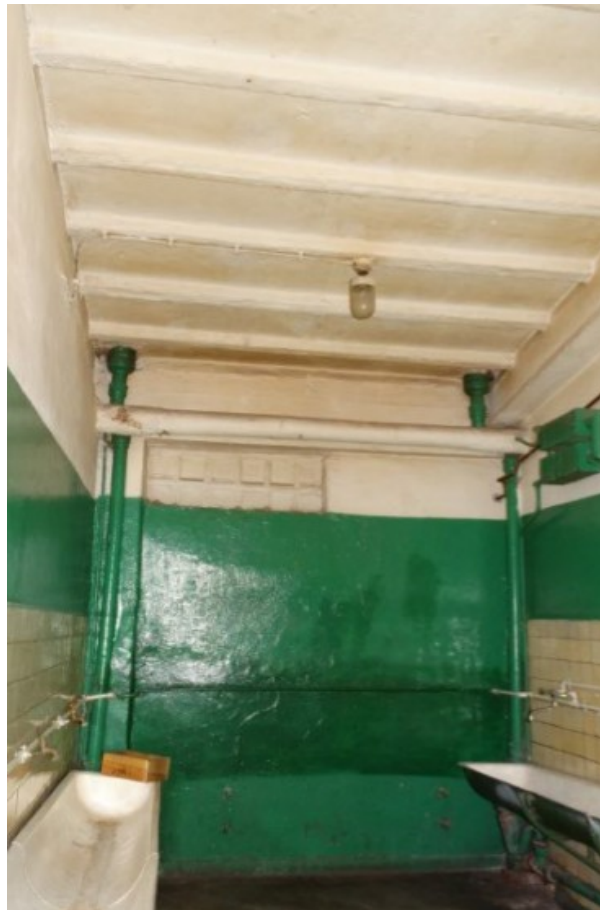
Fot 5 Widok konstrukcji dachu
