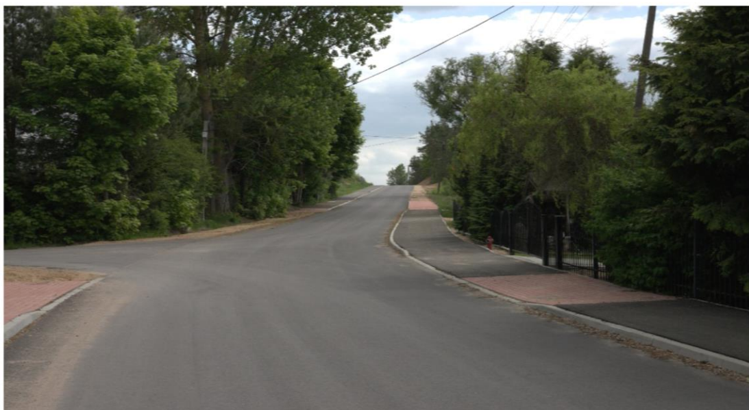
Droga Nr 1246B po przebudowie
