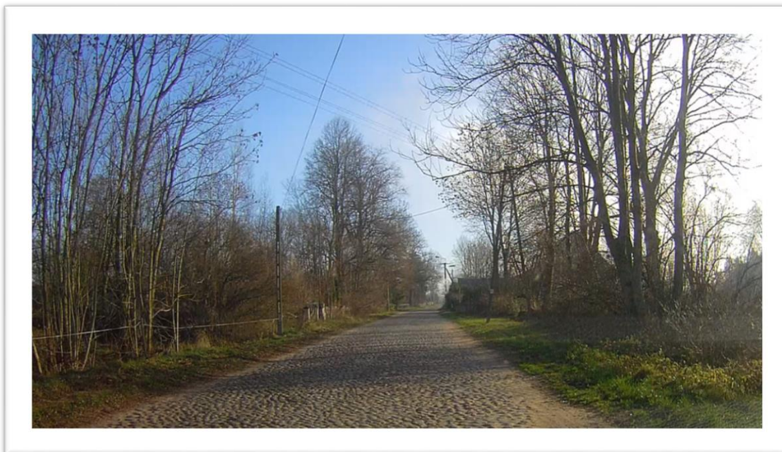
Droga nr 1259 B przed przebudową
