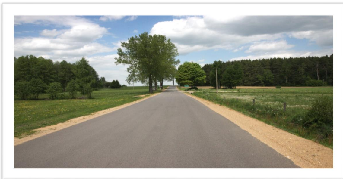
Droga nr 1259 po przebudowie
