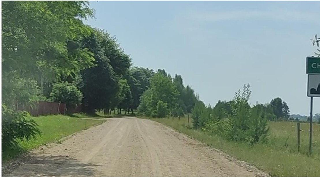
Droga Nr 1246 B przed przebudową
