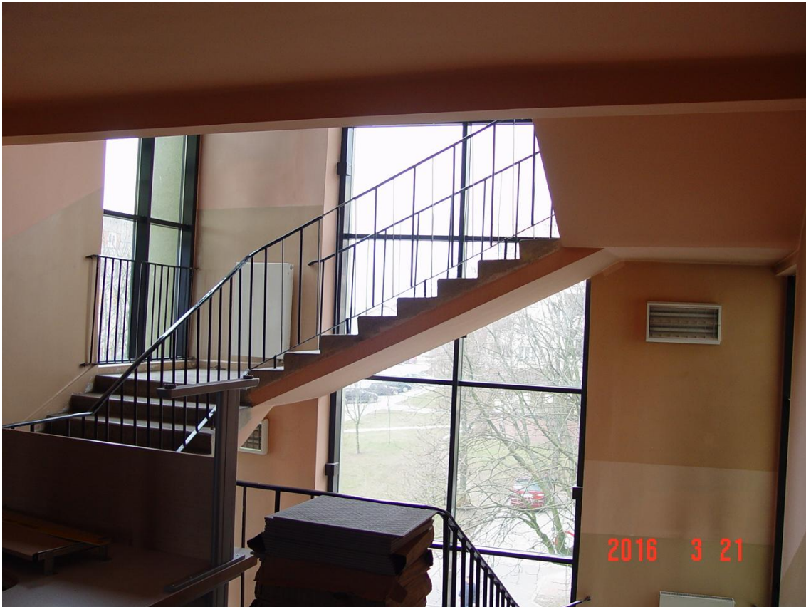
Fot. 1 Widok biegów klatki schodowej.
